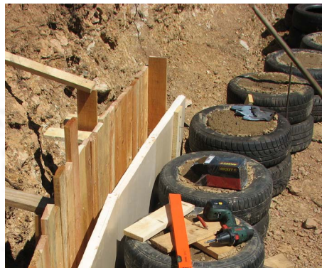
Voor de fundering van de stobalen in de buitenwand een rand autobanden, die met klei gevuld worden
