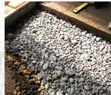
De vloer is opgebouwd uit een dikke laag grof grind, met daarop een laag klei
