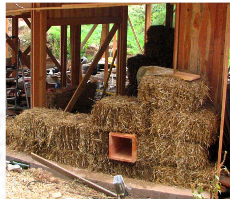
De gevel is gemaakt met gestapelde stobalen, die met klei worden afgewerkt
