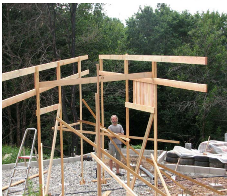
De houtconstructie is volledig gemaakt van planken van 3 bij 12 cm
